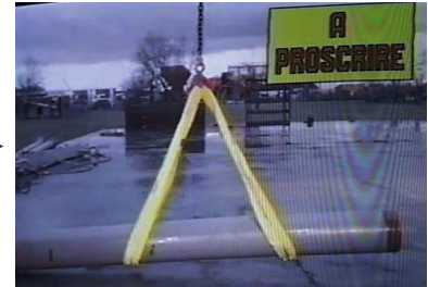
2 estropes travaillant en panier
