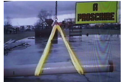
2 estropes travaillant en panier
