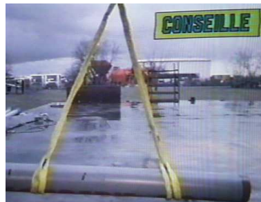
Nœud coulant 1 estrope et 2 brins
